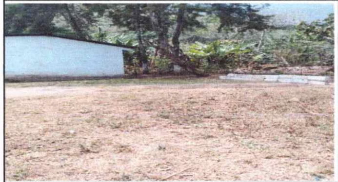
Foto 2. Sustitucion de muro perimetral
